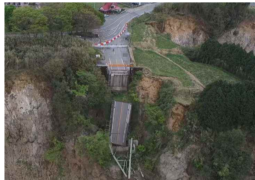
因山腰坍塌造成國道57號無法通行、斷橋之阿蘇大橋
