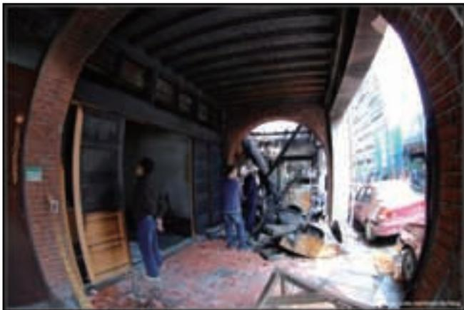
写真 4 騎楼(亭子脚)の木構造は表面炭化となった迪化街一段 270 号
