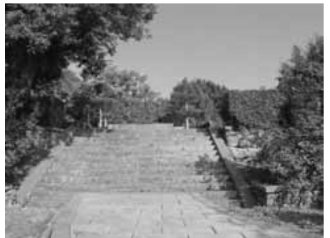
拝殿へ向かう石段。整備はされているものの、日本統治時代の位置関係は変わっていない。鳥居や参拝記念碑などは撤去されている。
