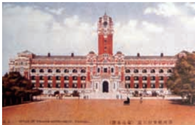
赤煉瓦の壁面に白帯を配する「辰野式」を踏襲した建物。戦前の絵はがきから。
