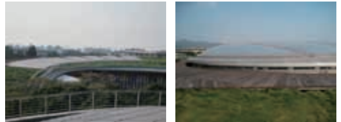
台北国際花卉博覧会メインパビリオンの屋上（左）とETFEを採用した温室の屋根
