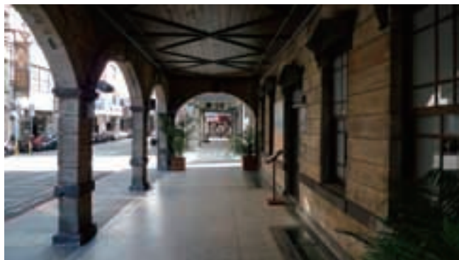
「亭仔脚（ていしきゃく）」と呼ばれる台湾式アーケード。石組みが基本で、火災にも耐えうる。この場合、石材は台北城の城壁に用いられていたものが転用されたと伝えられる。
