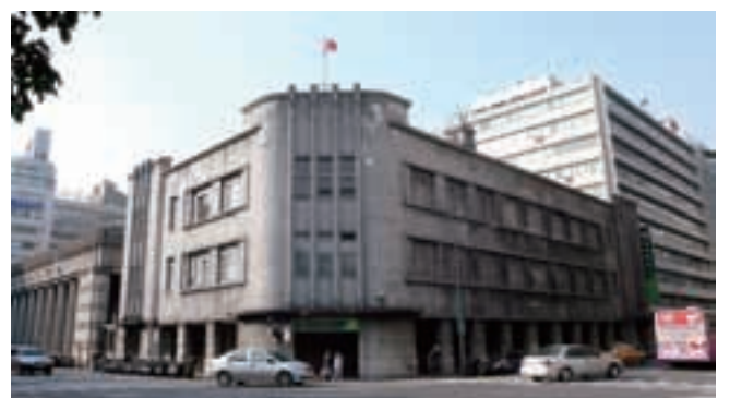
旧三井物産台北支店。現在は店舗としては使用されていない。オフィスビルらしい機能性を重視した建物だった。
