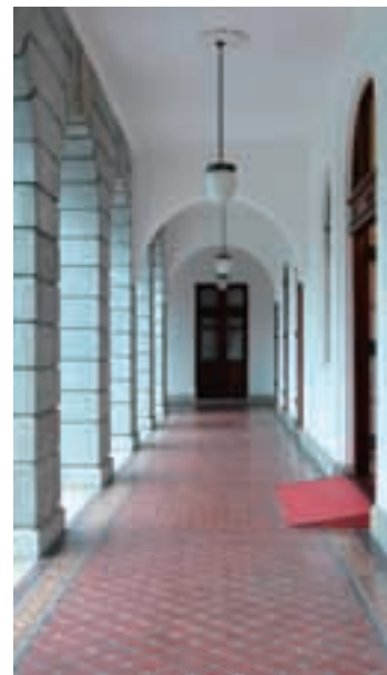
建物の四方にベランダが設けられているのもこの建物の特色。現在の姿になったのは1913年のこと。この工事を担当したのは森山松之助であった。
