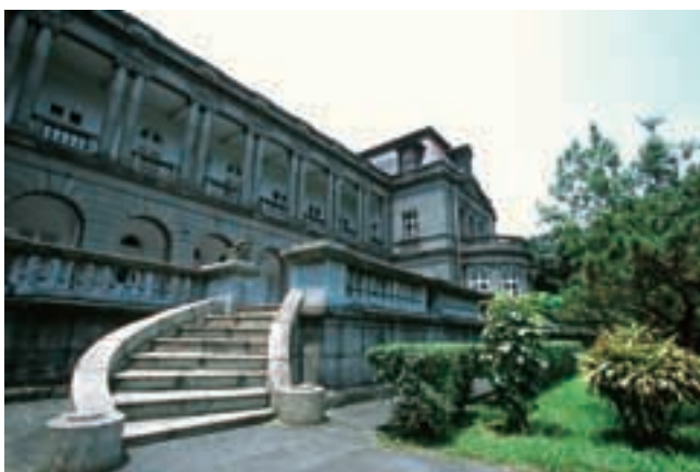
庭側からの様子。1階部は石組みのどっしりとした造りとなっており、安定感が示されている。
