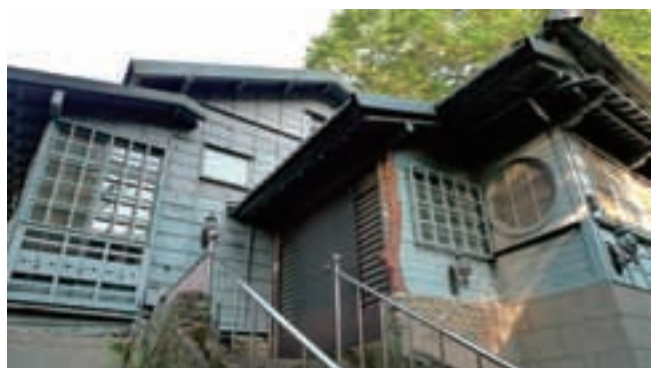
旧糸賀邸の様子。改装はされているものの、その趣きは歴史を感じさせる建物である。
