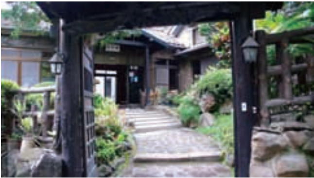
吟松閣。1937（昭和12）年に編まれた温泉案内には「吟松庵」と記されている。付近一帯は別荘地帯であった。木製の扉を開けると正面玄関がある。錦鯉が泳ぐ池を石橋で渡って玄関へと入っていく。
