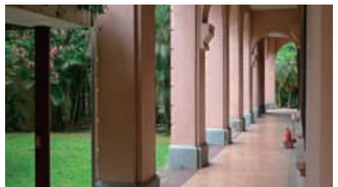
回廊部分の様子。2012年3月現在、この建物は使用されていないが、一般公開が模索されている。
