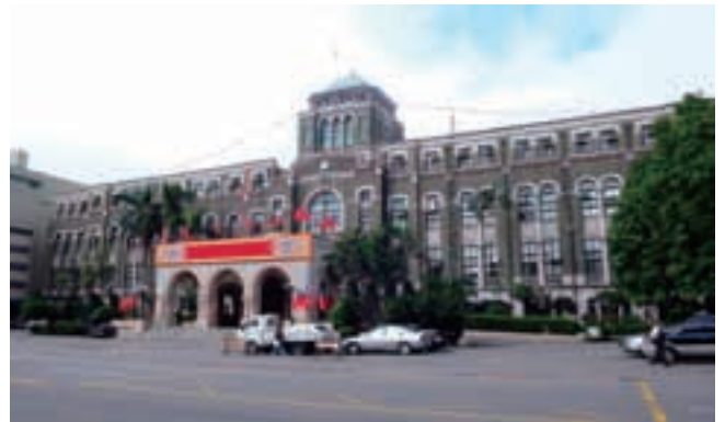
司法大廈全景。建物は台湾總督府と同様、真東を向いて建っている。これは本国遙拝を意識したものと言われている。
