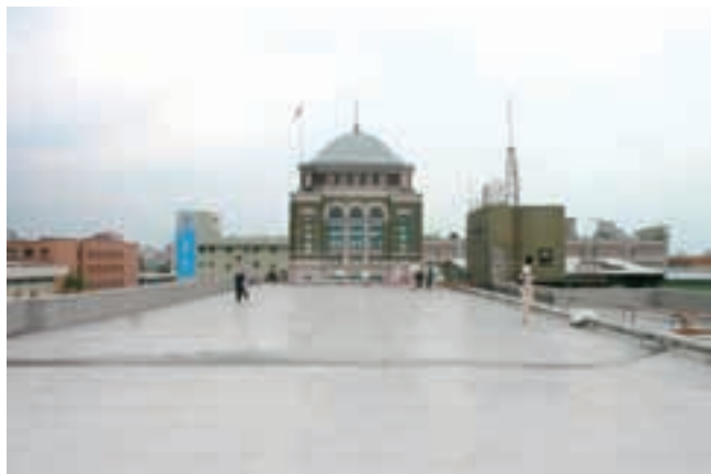
中央塔の屋根の部分は改修を経て大きく雰囲気が変わっている。
