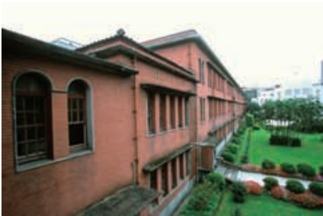
青島東路に面した校舎は1936年に造営されたものである。モダニズムの流れをくむ建物である。
