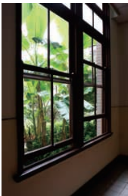
フリーストップ式の窓。機能が重視され、装飾などは見られませんが、階段や窓枠などに注目してみると、凝った作りであることが理解できる。
