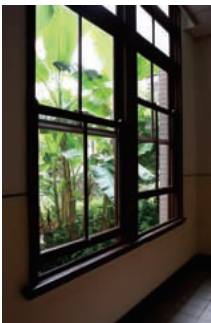
フリーストップ式の窓。機能性が重視され、装飾などは見られないが、階段や窓枠などに注目してみると、凝った作りであることが理解できる。
