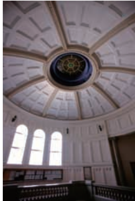
中央の大ドームを内部から見る。竣工時、ドームの外面には銅板が葺かれていた。
