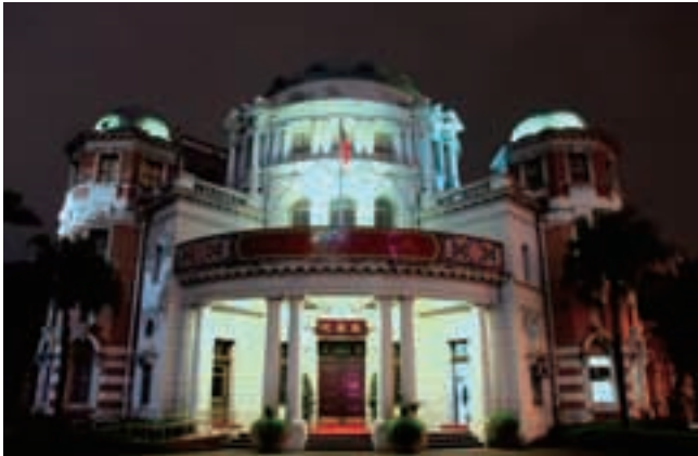
監察院。台湾を代表する官庁建築の一つだった。大小のドームを併せ持つ独特なたたずまい。事前申請をすれば、館内の見学も可能。夜間にはライトアップも施される。
