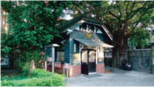
木造の守衛室は今も使用されている。戦前からの守衛室が残っているのは珍しい。
