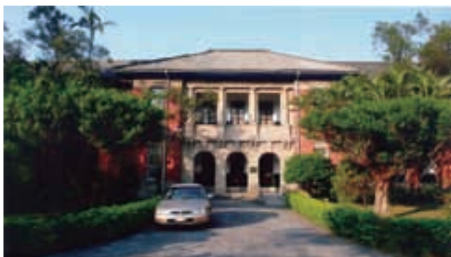
赤煉瓦に黒瓦という組み合わせの建築は、台湾では大正時代に入ってから見られるようになったものである。
