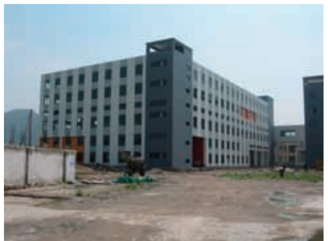
建設中の中小企業支援センター
