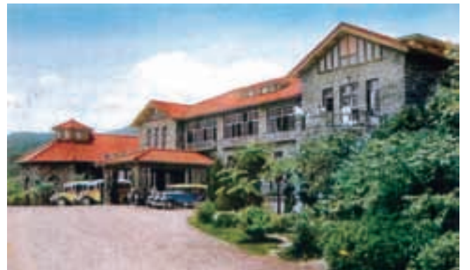
この建物には付近一帯で切り出した安山岩が多用されている。日本統治時代に発行された絵はがきより。
