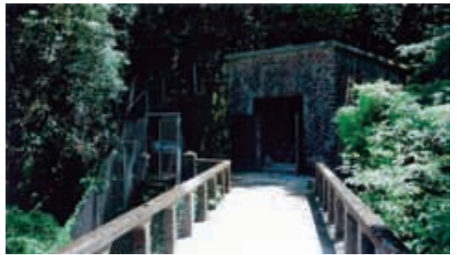
第三水源は水質の良さで知られ、東洋随一の湧泉とも評されていた。濾過を要さずそのまま飲用できたという。1943（昭和 18）年 7 月にはやや下流に第四水源も設けられた。
