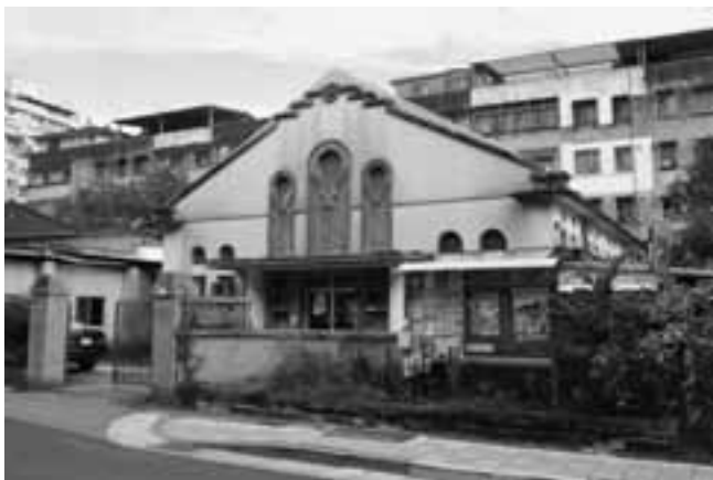
旧内湖庄役場会議室。円形窓と水平な庇。幾何学的なデザインが美しい。内湖庄が置かれたのは 1920 年。当時は台北市ではなく、台北州七星郡に属していた。
