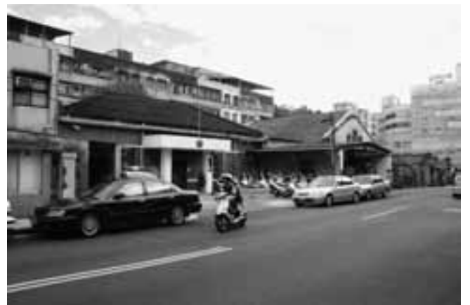
旧内湖庄役場。旧会議室に隣接する建物は旧内湖庄役場だった。竣工は 1937（昭和 12）年。1983 年からは派出所として使用されていたが、新しい警察署の建物が竣工してからは放置されていた。現在はすでに取り壊されている。
