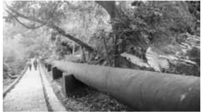
水源地から天母までを結んでいる送水管。現在も使用されており、文化財指定を受けている。
