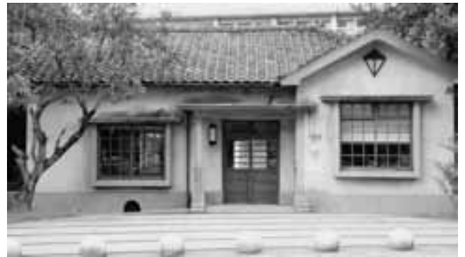
公民館として生まれ変わった木造官舎。公共スペースとして整備されている。向かいには文山區行政中心（区役所）がある。
