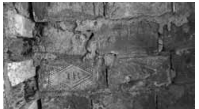
建物の壁面に見られた「TR 煉瓦」。日本統治時代に台湾煉瓦会社が製造した耐火煉瓦である。
