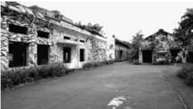
日本統治時代の建物は3棟残っている。いずれも装飾を排したシンプルなデザインである。
