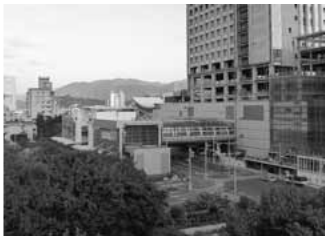
建設工事が進められている南港駅の様子。在来線とMRTの接続駅で、将来は台湾高速鉄道もここに延伸してくる。手前は南港瓶蓋工廠の敷地内の樹木。
