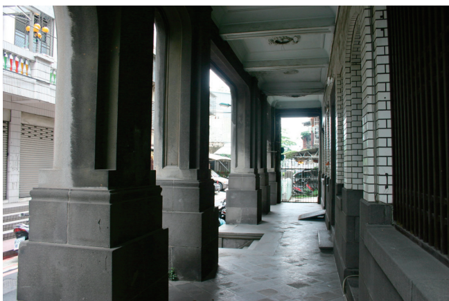
淡水河の氾濫を意識し、高床構造となっている。
