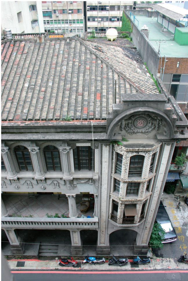
貴徳街は狭い路地だが、両脇にはぎっしりと建物が並んでいる。この写真は向かいに建っている高層マンションの一室から撮影したもの。
