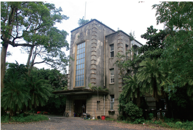
工場建築群の設計は梅澤捨次郎が行なっている。梅澤は台南市の旧台南銀座の設計で知られており、昭和期に建築に深くかかわった技師である。写真は修復工事が施される前の様子。
