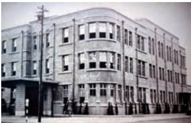
基隆市役所。現在も市政府（市役所）として使用されている。当初は3階建てだったが、1966年に増築されて4階となった。
