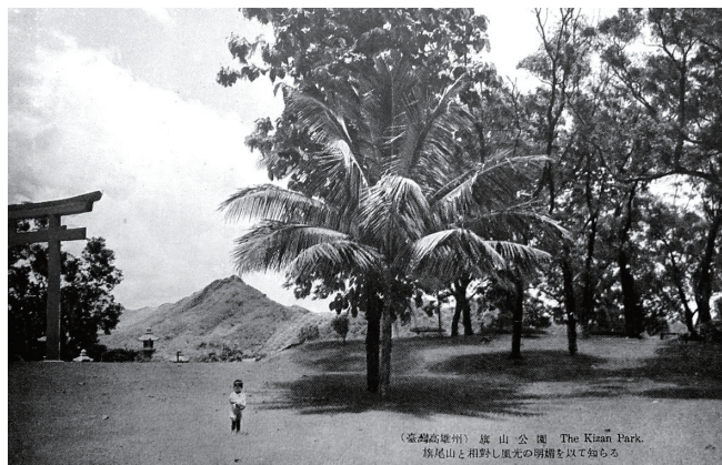
写真 29 鼓山公園は旗山神社が鎮座していた場所で、敷地全体が神苑とされていた。中央の奥に見えるのは旗尾山。日本統治時代の絵はがき。
