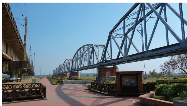
写真16 鉄道遺産として保存されている旧橋梁。現在、河川敷は公園として整備されている。残念ながら、現在は中程の橋脚が洪水により、流されている。
