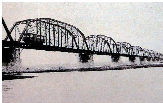
写真17 トラスが連なる様子。日本統治時代の名は下淡水溪橋梁であった。屏東地区の発展に大きく貢献した。日本統治時代に発行された絵はがき。
