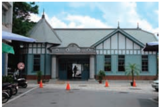
写真 21 現在の旗山駅の様子。線路はすでに剥がされているが、駅舎は修復工事を経て公共空間となっている。
