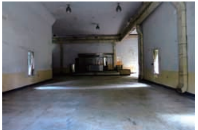
写真 15 第二送信所は屋内に通信施設の一部が残っている。厚い壁が重苦しい雰囲気を出している。
