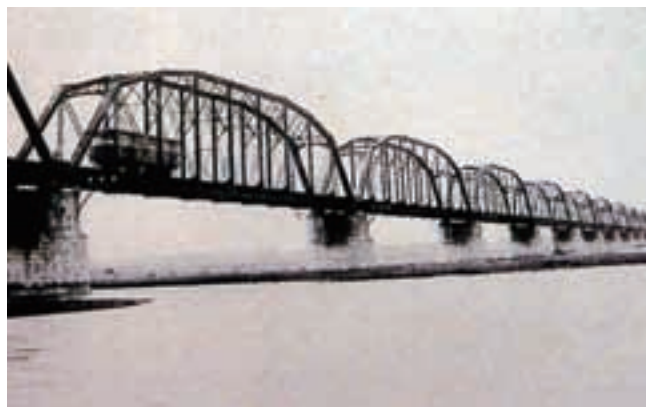
写真17 トラスが連なる様子。日本統治時代の名は下淡水溪橋梁であった。屏東地区の発展に大きく貢献した。日本統治時代に発行された絵はがき。
