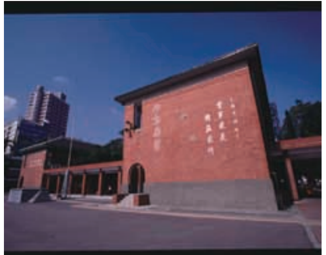
旧制高雄中学は1927（昭和2）年に第一回目の卒業生を輩出している。当時の修業年限は5年であった。
