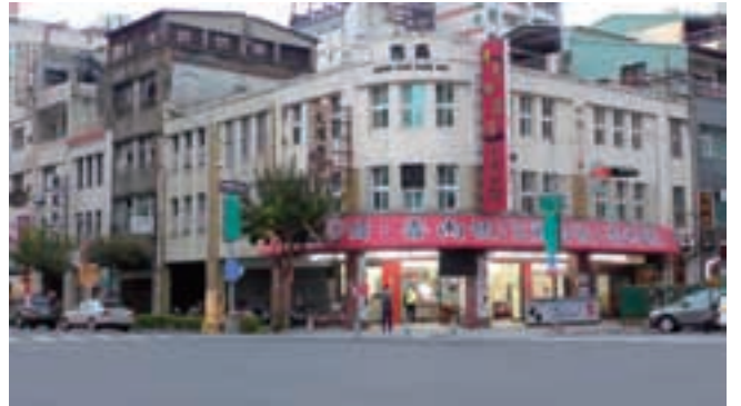
写真6 高雄銀座商店街。戦後は國際商場と名を変えた。現在も建物は残っている。
