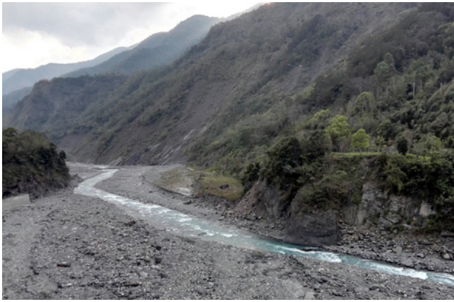
南部横貫公路沿線は 2009 年 8 月 8 日の水害で大きな被害が出た。大量の土砂で埋まった谷の様子。
