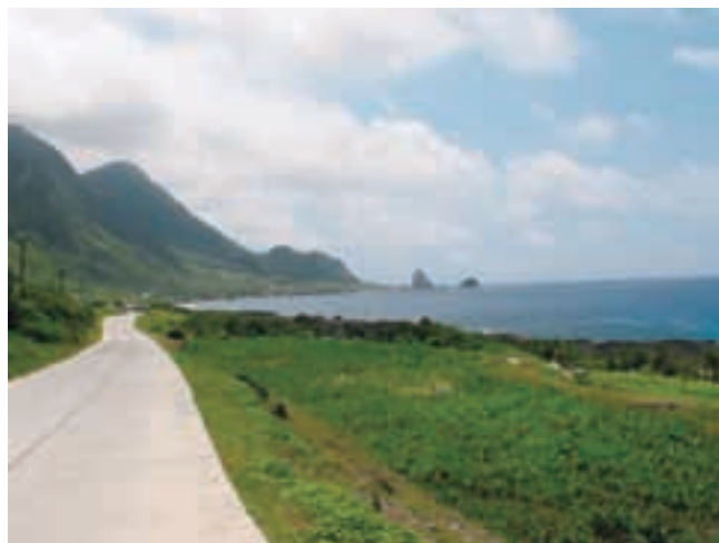
島の外周を走る環島公路の様子。
