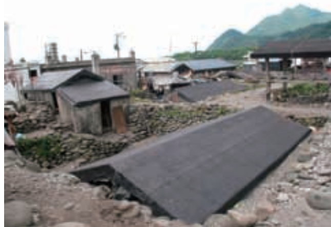
バウイと呼ばれる伝統家屋。半地下式の高床式家屋である。現在は野銀と朗島に残るばかりとなっている。
