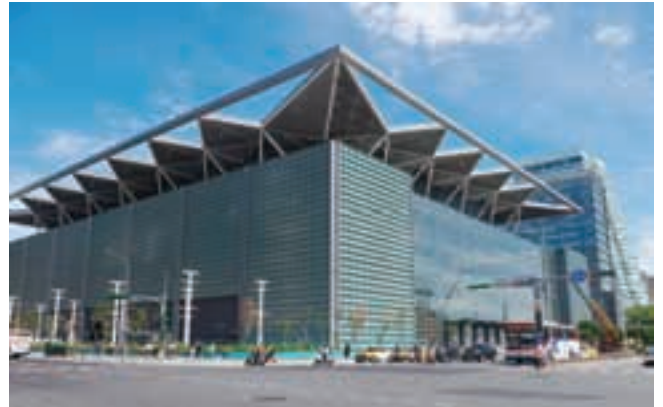
写真 25 2019 年には南港 hall2 が完成予定、来年は会場を拡大しての開催となる
