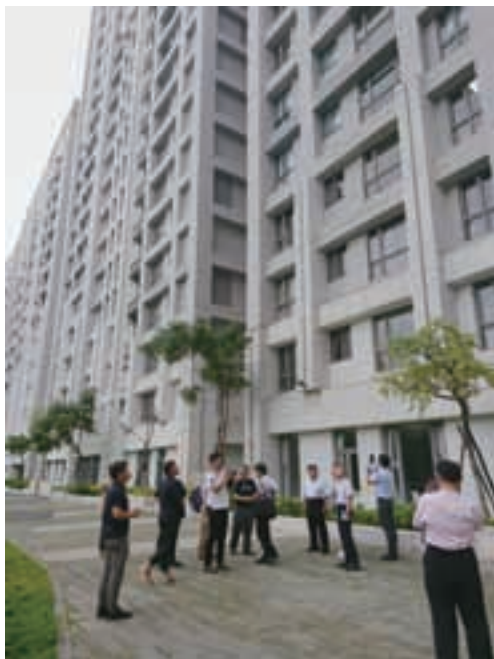
写真 19 外観は住居用のマンション、何棟もの建物が建ち並ぶ一角に TST がある
