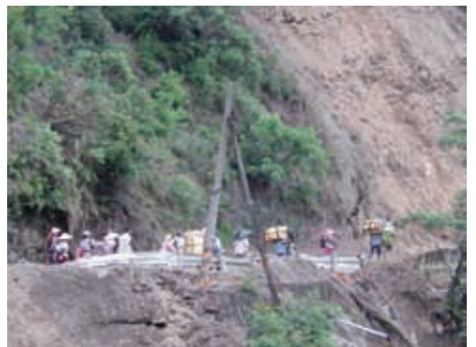
大禹嶺 崩落した道路
