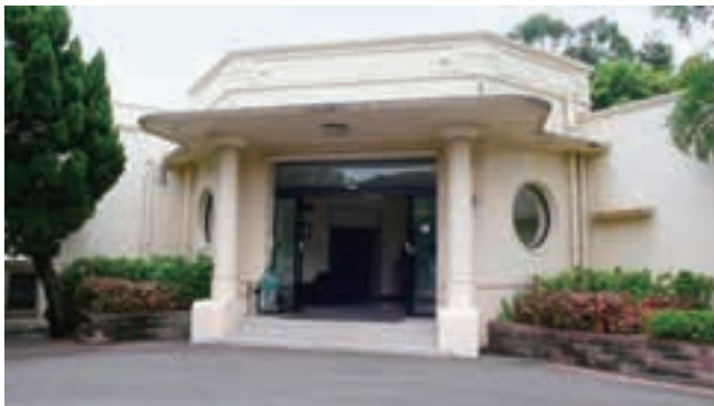
新竹水源地は市街地の東、十八尖山に設けられていた。竣工は1929(昭和4)年3月。現在も濾過池が保存されているほか、遙拝所の石段やポンプ室が残っている。
