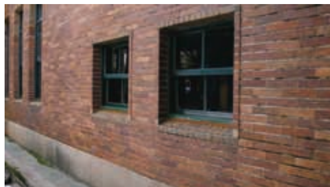
壁には意図的に縦型の傷を付けた「スクラッチタイル」が貼られている。
