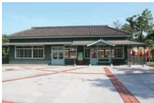
木造駅舎が残る北門駅。現在は歴史建築として保存されている。駅周辺の様子も往時の雰囲気を留めている。
