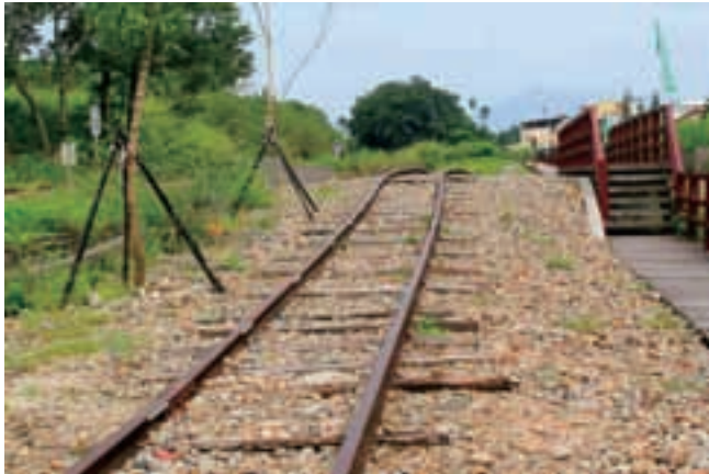
台湾中部大震災の傷跡。濁水駅近くでは線路が断層によってねじ曲がり、送電塔が傾いた状態になった。現在は公園となっている。
