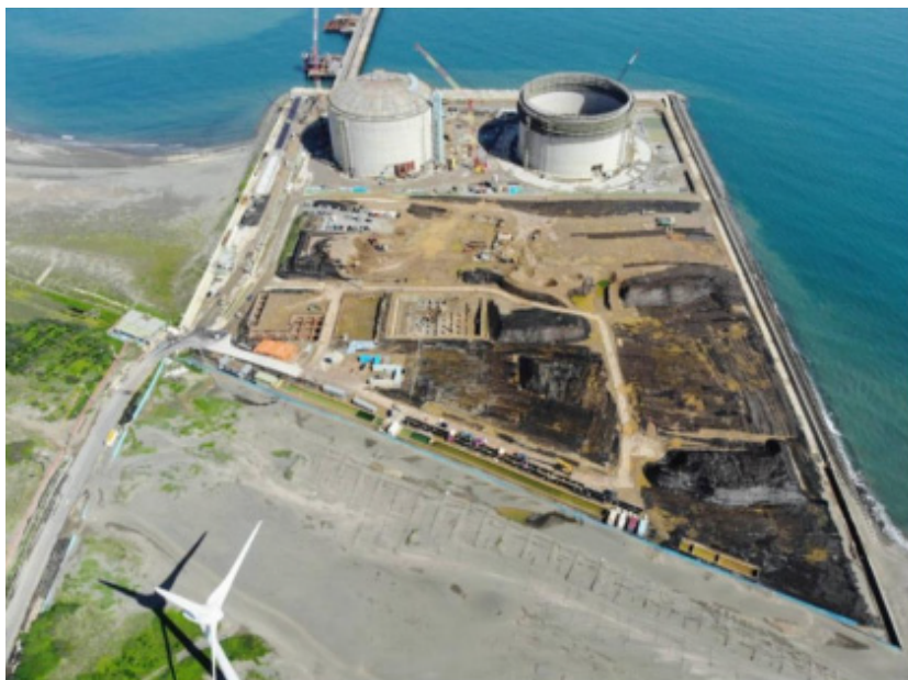
写真1 建設中の天然ガス第3ターミナル（桃園海岸沿い）
