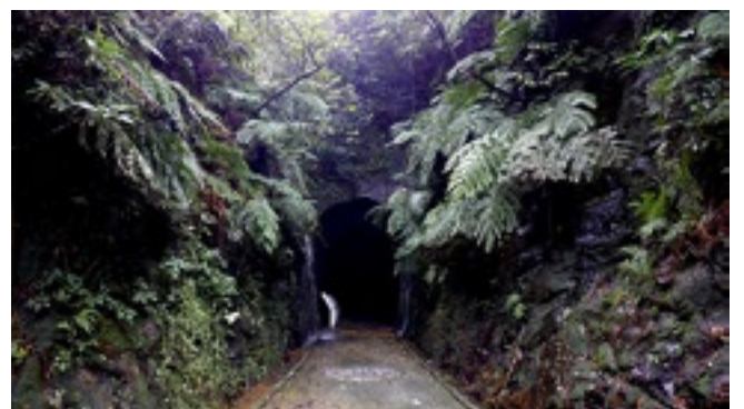
劉銘傳の治世下、刷新と防衛の強化は同時進行で行なわれていった。現在も基隆郊外に残る清国統治時代のトンネル「獅球嶺隧道」。
