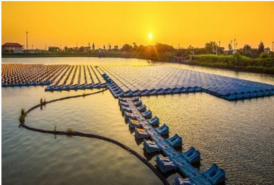
図4 ため池での浮上式太陽光発電（桃園市）
