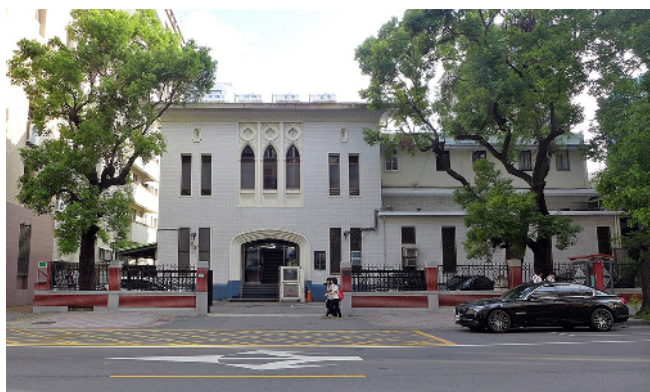
七星郡役所。役場は台北市内に設けられていた。建物は現存するが、議員会館となっており、館内の見学はできない。『台北・歴史建築探訪』より。
