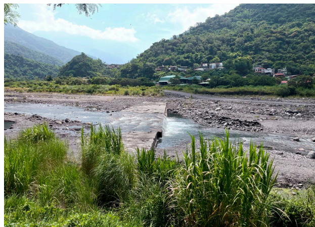
林辺溪を横断する地下堰の上部が川岸から見える
