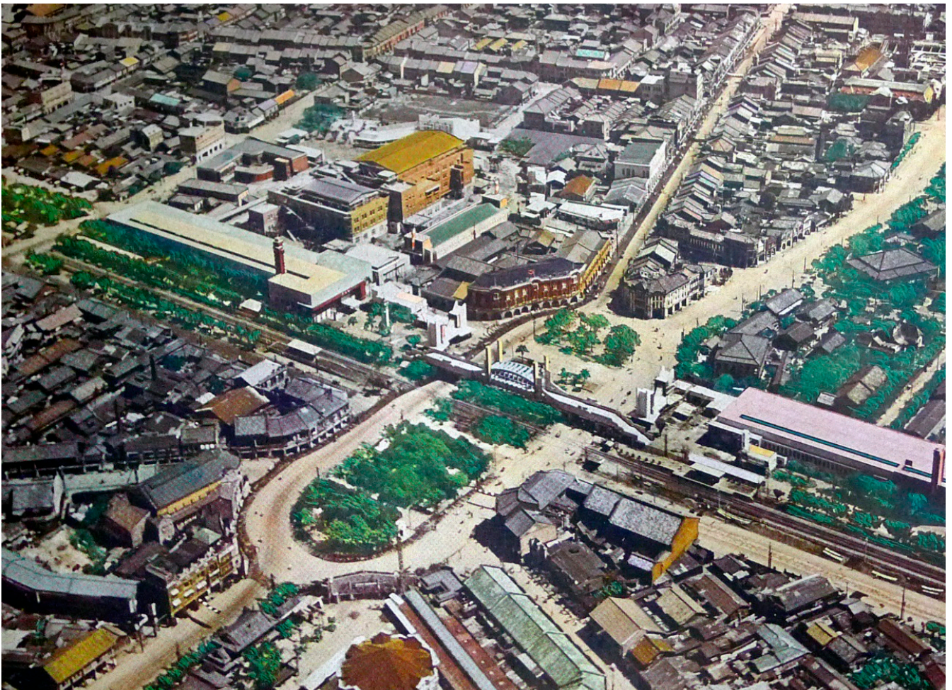
日本統治時代に撮影された俯瞰写真。中央に台北公会堂と楢円公園、そして、新起町ガソリンカー停留所が見える。1935（昭和10）年当時の様子。楢円公園の南には八角堂（現在の西門紅楼）の屋根も見える。『始政四十周年記念博覧会画帳』より転載。
