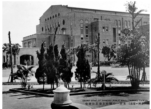
旧台北公会堂は孫文にちなんで中山堂と呼ばれている。建物は地上4階建てで、総面積は1237坪あまり。竣工時、東京、大阪、名古屋の各公会堂に次ぐ規模だった。富永勝氏所蔵。
