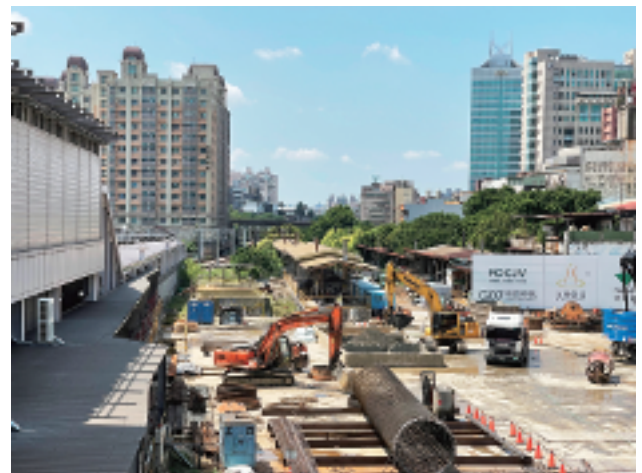
桃園駅は大がかりな改良工事が行なわれている。現在は仮駅舎で営業しており、将来は地下駅となる予定。
