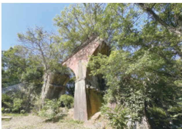
地震によって瓦解した橋脚。現在は史跡に指定されている。
