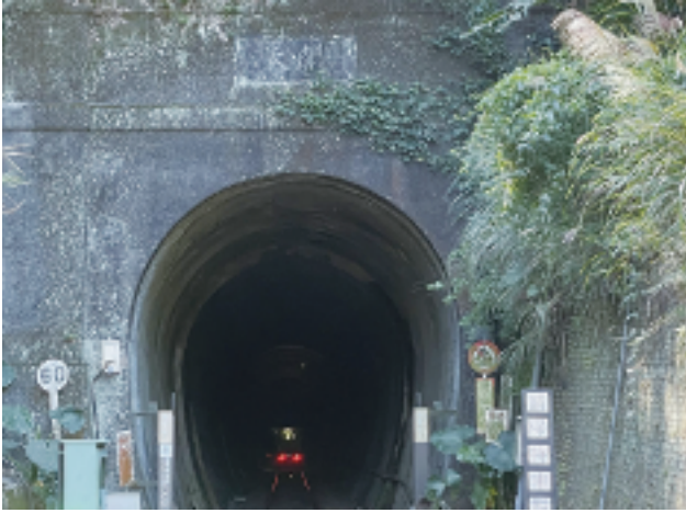
二号隧道と後藤新平揮毫のプレート。なかば苔むしているが「開天」の文字はわずかに確認できる。
