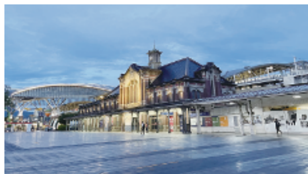
台中駅の旧駅舎。英国風の雰囲気をもった駅舎は竣工以来、台中のシンボルとなっている。鉄道は高架化されたが、駅舎はその姿を留めている。
