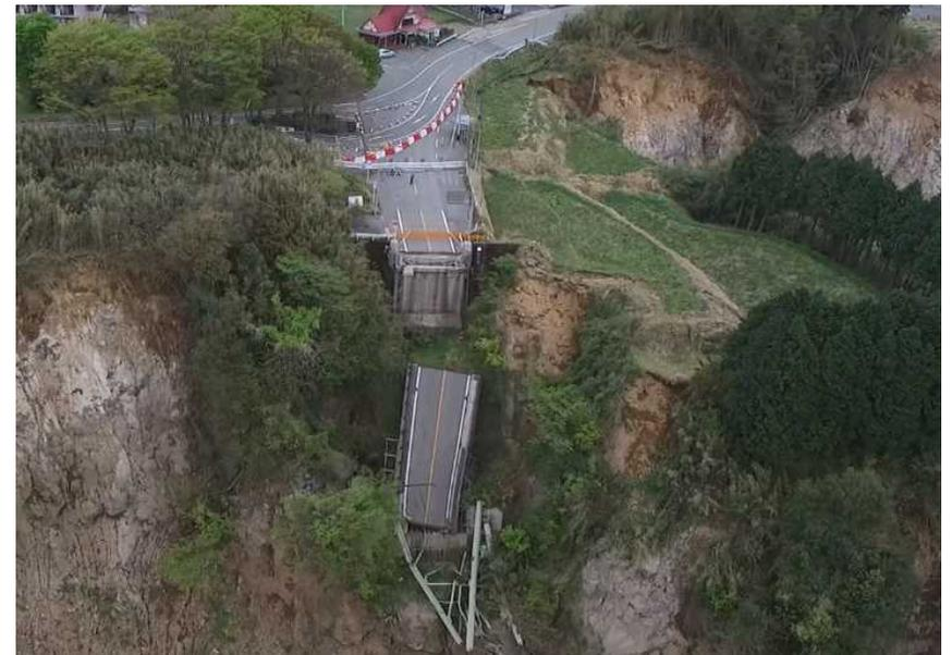
山腹崩壊により通行不能となった国道57号、落橋した阿蘇大橋
