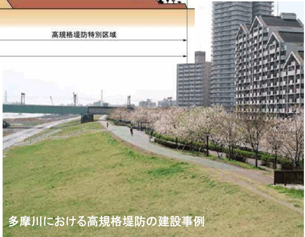
多摩川における高規格堤防の建設事例
