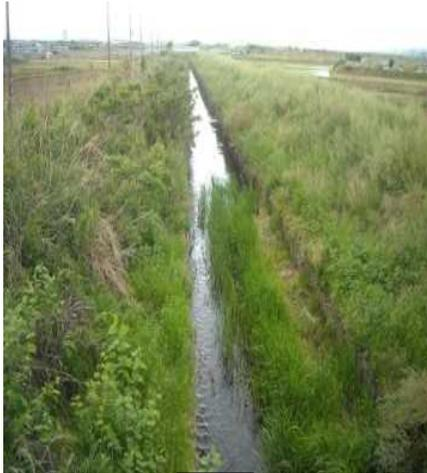
脆弱な堤防の機能強化を図るとともに断面を拡大し治水安全度が向上
