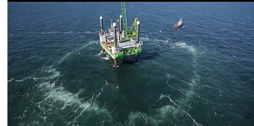
エアバブルカーテンを生成して工事を実施する様子
