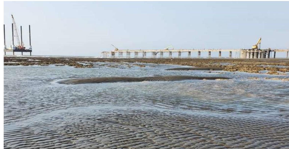
建設中の台湾中国石油(CPC)第三LNGターミナル(桃園・觀塘)。出典:CPC。
